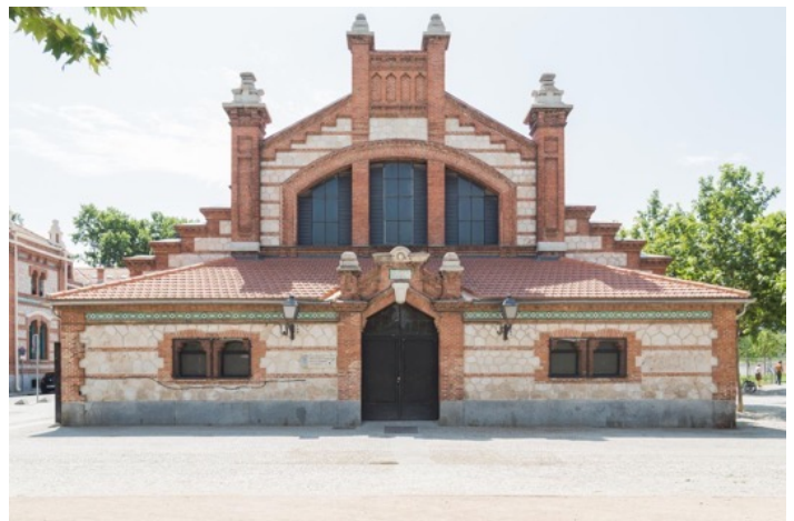
Nave de Ternerias
